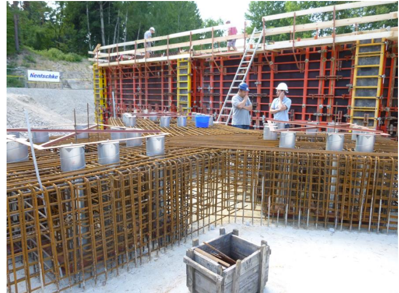
Juli 2013: Konstruktion des Fundaments
