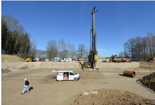
April 2013: Bohren der 22 m tiefen Löcher für 7 Säulen
